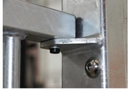
Todos los componentes de acero están fabricados con acero al carbono, soldadura según EN ISO 5817 y galvanizado en caliente (HDG) según ISO1461. Este proceso garantiza una buena protección en todas las circunstancias.
