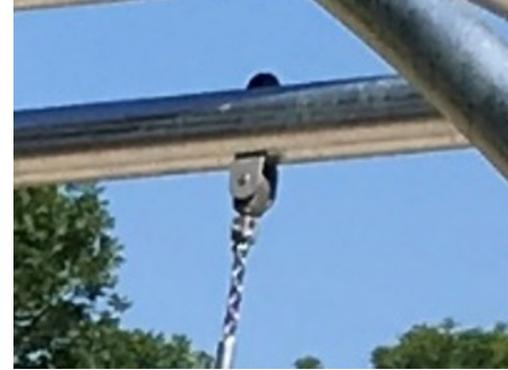
Colgadores de acero inoxidable con diseño exclusivo con función anti-giro. Las perchas están unidas a la viga transversal mediante un tornillo a través de la conexión para garantizar una alta durabilidad.
