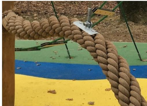
La cuerda de PP en estilo coco tiene un diámetro de 15 cm. El núcleo interno de alambre de acero tiene dedales en ambos extremos, que sirven como accesorios para la cuerda a los elementos de conexión existentes.
